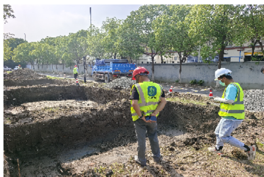
设备基础开挖
