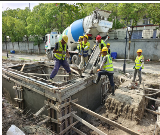
圈梁及构造柱浇筑
