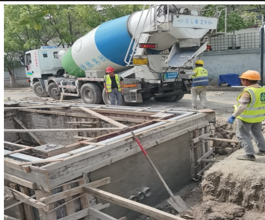
圈梁及构造柱浇筑
