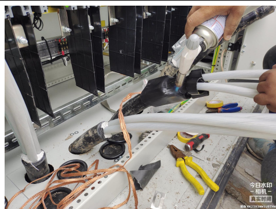
变压器低压电缆终端制作
