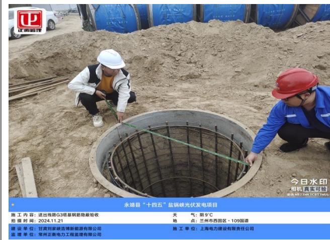
永靖县“十四五”盐锅峡光伏发电项目 施工内容: 送出线路G3塔基钢筋隐蔽验收 拍摄时间: 2024.11.21 建设单位: 甘肃刘家峡清洁能源有限公司 监理单位: 常州正泰电力工程监理有限公司 天气: 阴 9°C 地点: 兰州市西固区·109国道 施工单位: 上海电力建设有限责任公司
