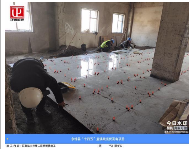
永靖县“十四五”盐锅峡光伏发电项目 施工内容: 汇集站主控楼二层地板砖施工 拍摄时间: 2024.11.21 建设单位: 甘肃刘家峡清洁能源有限公司 监理单位: 常州正泰电力工程监理有限公司 天气: 阴 9°C
