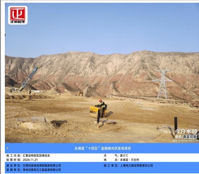
永靖县“十四五”盐锅峡光伏发电项目 施工内容: 汇集站构架区回填压实 拍摄时间: 2024.11.21 建设单位: 甘肃刘家峡清洁能源有限公司 监理单位: 常州正泰电力工程监理有限公司 天气: 雾 0°C 地点: 永靖县·方台村 施工单位: 上海电力建设有限责任公司
