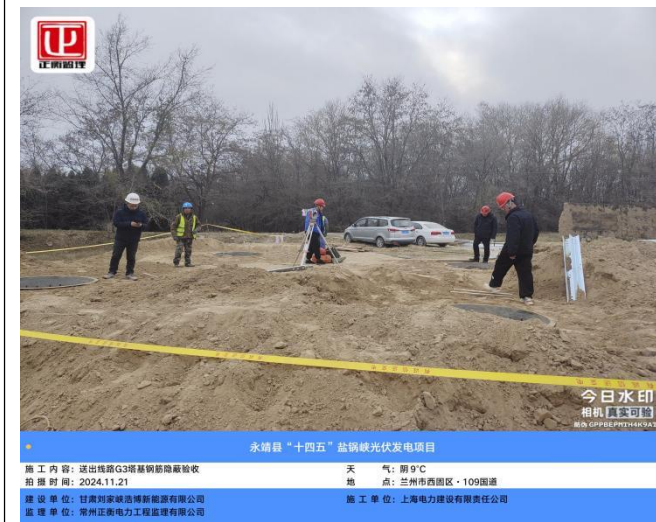
永靖县“十四五”盐锅峡光伏发电项目 施工内容: 送出线路G3塔基钢筋隐蔽验收 拍摄时间: 2024.11.21 建设单位: 甘肃刘家峡清洁能源有限公司 监理单位: 常州正泰电力工程监理有限公司 天气: 阴 9°C 地点: 兰州市西固区·109国道 施工单位: 上海电力建设有限责任公司
