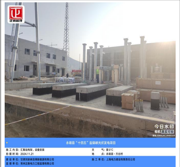
永靖县“十四五”盐锅峡光伏发电项目 施工内容: 汇集站构架、设备安装 拍摄时间: 2024.11.21 建设单位: 甘肃刘家峡清洁能源有限公司 监理单位: 常州正泰电力工程监理有限公司 天气: 雾 0°C 地点: 永靖县·方台村 施工单位: 上海电力建设有限责任公司
