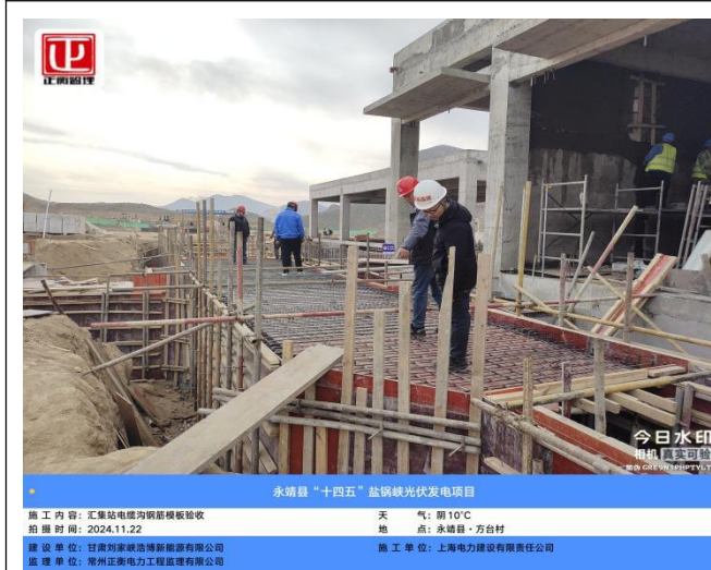
汇集站电缆沟钢筋模板验收
