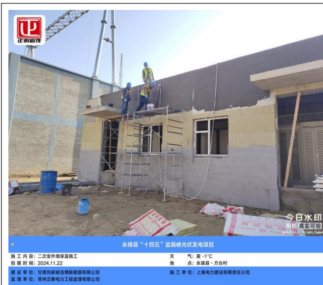
二次室外墙保温施工
