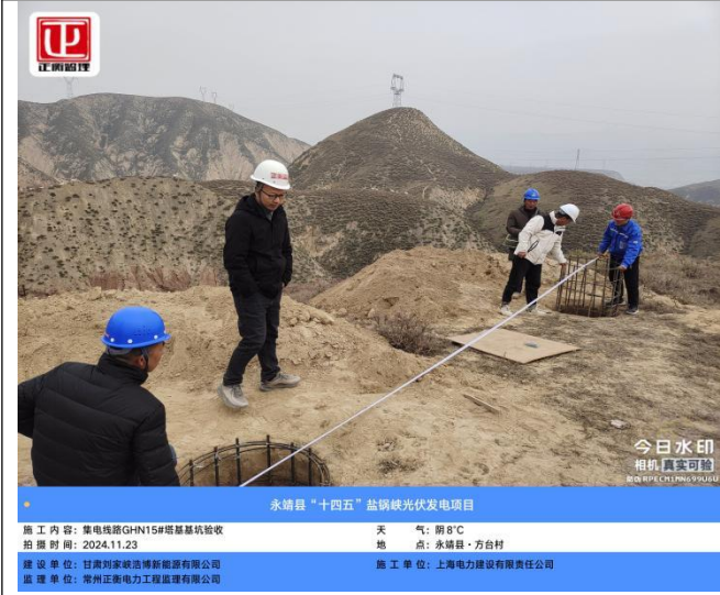
永靖县“十四五”盐锅峡光伏发电项目 施工内容: 集电线路GHN15#塔基坑验收 天气: 阴 8°C 拍摄时间: 2024.11.23 地点: 永靖县·方台村 建设单位: 甘肃刘家峡清洁能源有限公司 监理单位: 常州正衡电力工程监理有限公司 施工单位: 上海电力建设有限公司
