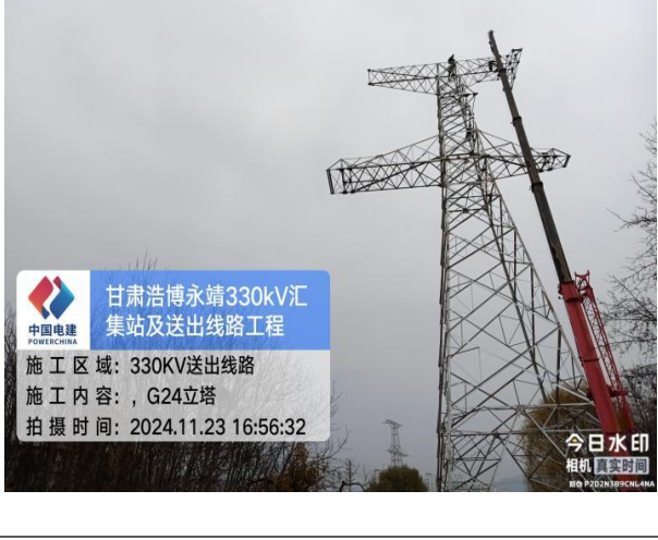
甘肃浩博永靖330kV汇集站及送出线路工程 施工区域: 330KV送出线路 施工内容: G24立塔 拍摄时间: 2024.11.23 16:56:32
