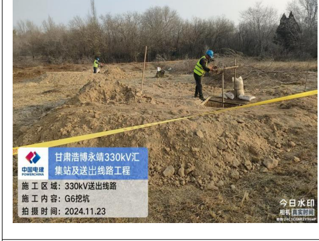
甘肃浩博永靖330kV汇集站及送出线路工程 施工区域: 330kV送出线路 施工内容: G6挖坑 拍摄时间: 2024.11.23
