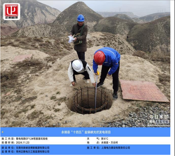
永靖县“十四五”盐锅峡光伏发电项目 施工内容: 集电线路EF12#塔基坑验收 天气: 阴 8°C 拍摄时间: 2024.11.23 地点: 永靖县·方台村 建设单位: 甘肃刘家峡清洁能源有限公司 监理单位: 常州正衡电力工程监理有限公司 施工单位: 上海电力建设有限公司
