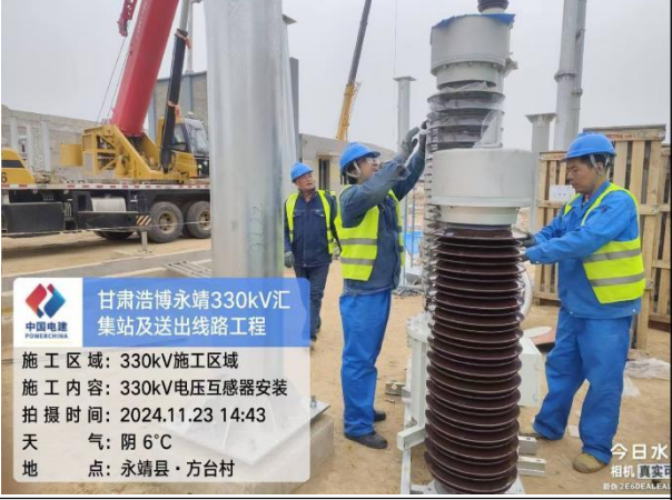
甘肃浩博永靖330kV汇集站及送出线路工程 施工区域: 330kV施工区域 施工内容: 330kV电压互感器安装 拍摄时间: 2024.11.23 14:43 天气: 阴 6°C 地点: 永靖县·方台村
