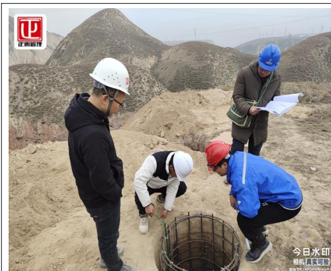
集电线路基坑验收
