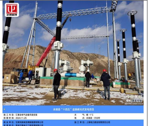
汇集站电气设备吊装安装
