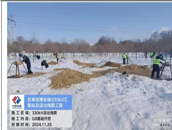
送出线路塔基基础开挖
