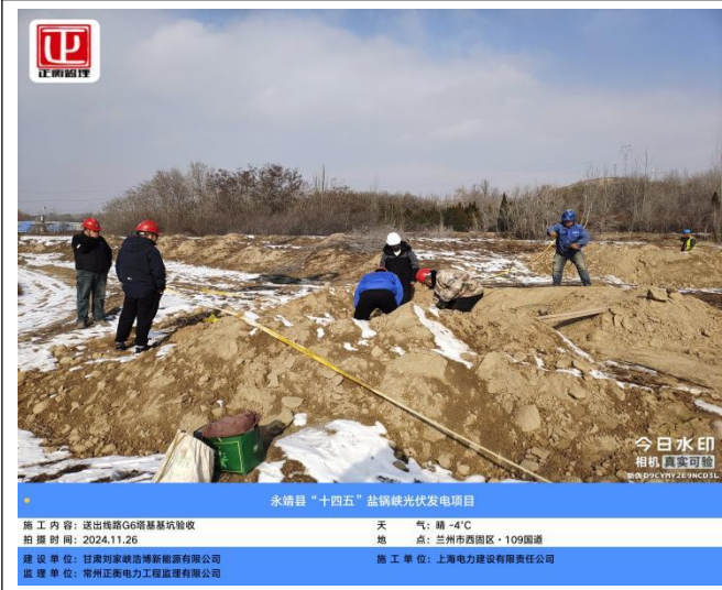
送出线路 G6 塔基基坑验收
