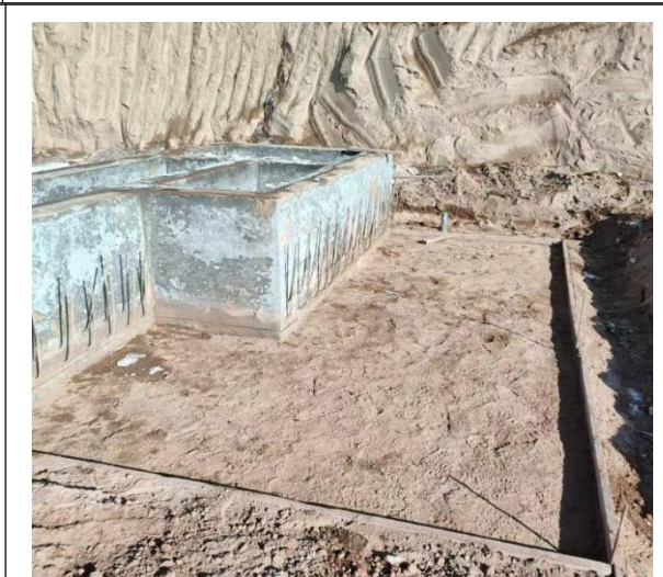
箱变基础施工
