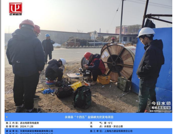
永靖县“十四五”盐锅峡光伏发电项目 施工内容: 送出线路导线盘测 天气: 雾-5℃ 拍摄时间: 2024.11.28 地点: 永靖县·折达公路 建设单位: 甘肃刘家峡清洁能源有限公司 监理单位: 常州正衡电力工程监理有限公司 施工单位: 上海电力建设有限公司
