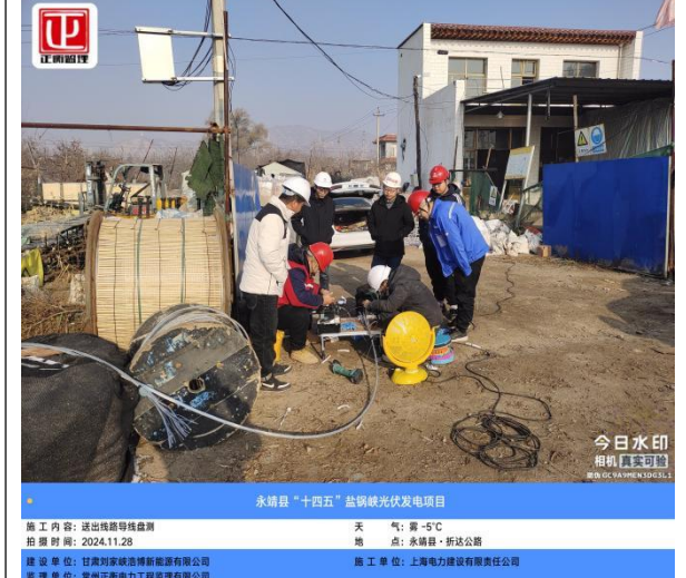
永靖县“十四五”盐锅峡光伏发电项目 施工内容: 送出线路导线盘测 天气: 雾-5℃ 拍摄时间: 2024.11.28 地点: 永靖县·折达公路 建设单位: 甘肃刘家峡清洁能源有限公司 监理单位: 常州正衡电力工程监理有限公司 施工单位: 上海电力建设有限公司
