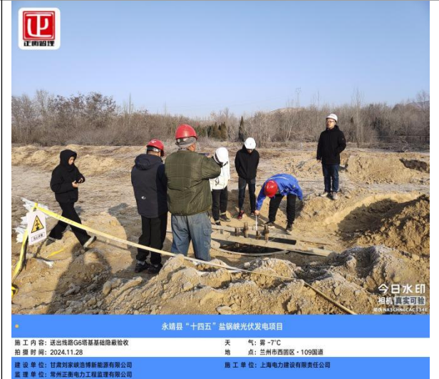
永靖县“十四五”盐锅峡光伏发电项目 施工内容: 送出线路G6塔基基础隐蔽验收 天气: 雾-7℃ 拍摄时间: 2024.11.28 地点: 兰州市西固区·109国道 建设单位: 甘肃刘家峡清洁能源有限公司 监理单位: 常州正衡电力工程监理有限公司 施工单位: 上海电力建设有限公司
