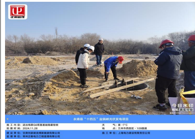
永靖县“十四五”盐锅峡光伏发电项目 施工内容: 送出线路G6塔基基础隐蔽验收 天气: 雾-7℃ 拍摄时间: 2024.11.28 地点: 兰州市西固区·109国道 建设单位: 甘肃刘家峡清洁能源有限公司 监理单位: 常州正衡电力工程监理有限公司 施工单位: 上海电力建设有限公司
