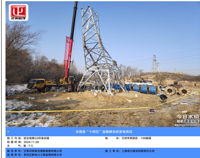
永靖县“十四五”盐锅峡光伏发电项目 施工内容: 送出线路G3吊装塔组 天气: 雾-7℃ 拍摄时间: 2024.11.28 地点: 兰州市西固区·109国道 建设单位: 甘肃刘家峡清洁能源有限公司 监理单位: 常州正衡电力工程监理有限公司 施工单位: 上海电力建设有限公司
