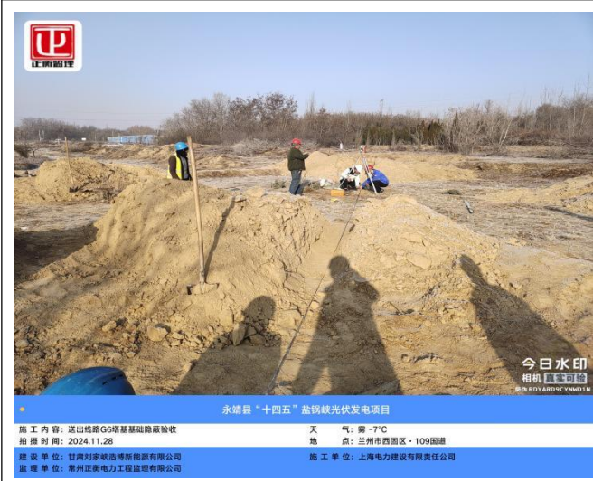
永靖县“十四五”盐锅峡光伏发电项目 施工内容: 送出线路G6塔基基础隐蔽验收 天气: 雾-7℃ 拍摄时间: 2024.11.28 地点: 兰州市西固区·109国道 建设单位: 甘肃刘家峡清洁能源有限公司 监理单位: 常州正衡电力工程监理有限公司 施工单位: 上海电力建设有限公司
