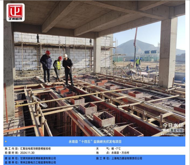
电缆沟浇筑前验收
