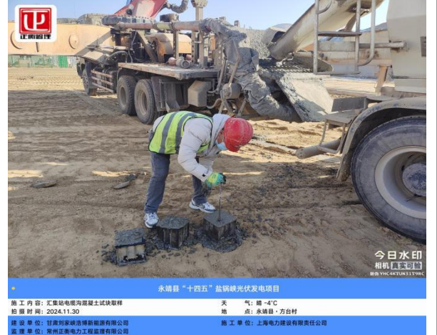
混凝土试块取样
