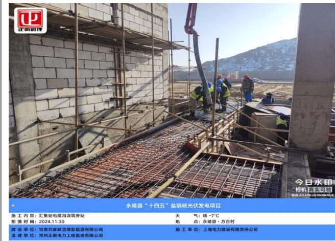
电缆沟浇筑旁站
