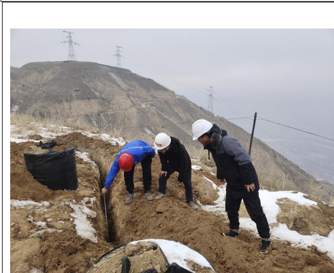
集电线路接地沟验收
