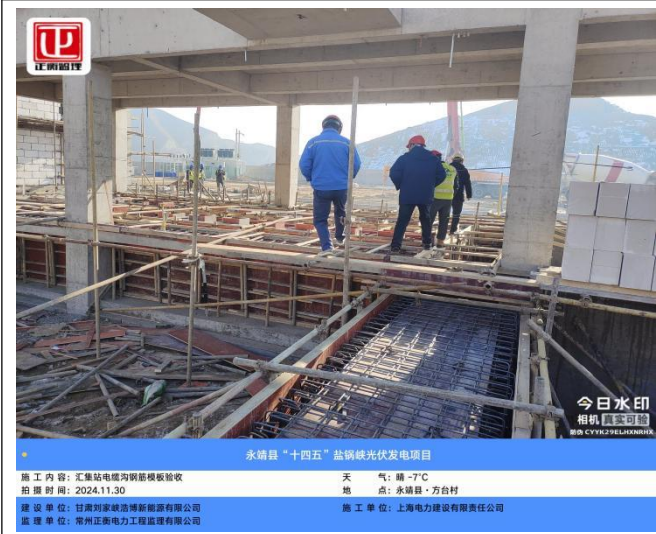
电缆沟浇筑前验收
