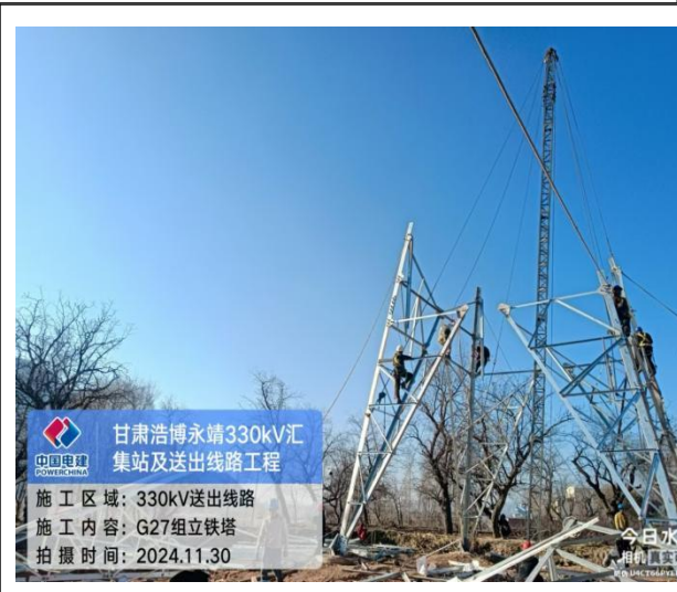
送出线路铁塔吊装
