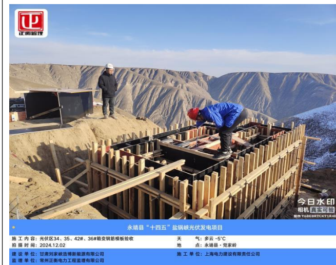
箱变钢筋、模板施工验收检查
