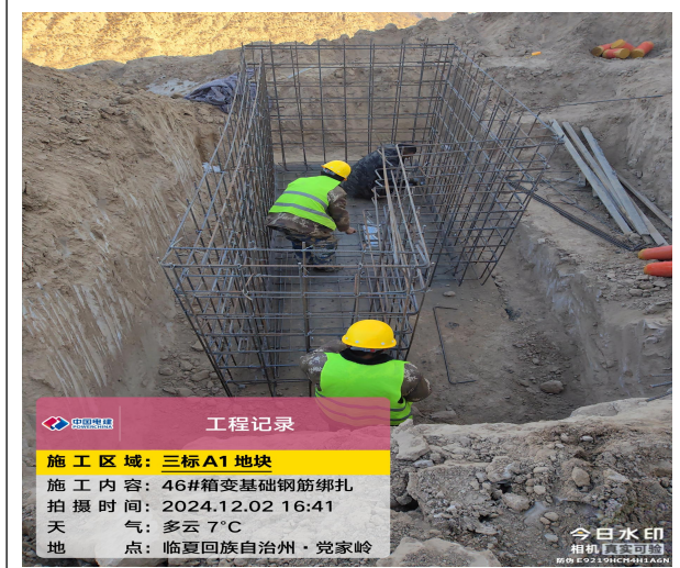
箱变钢筋施工
