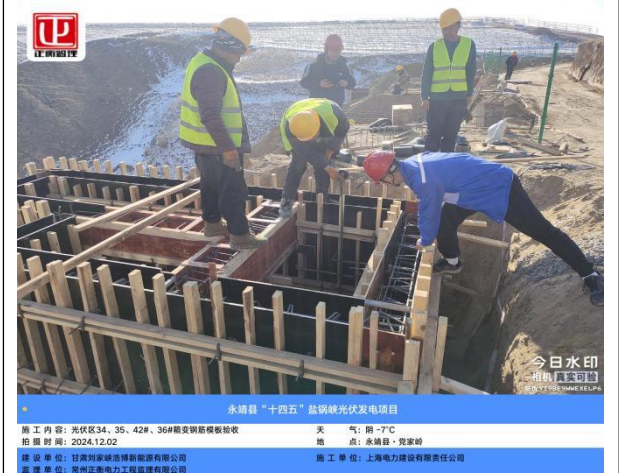
光伏区箱变钢筋/模板验收
