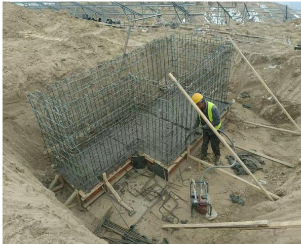
箱变基础钢筋施工
