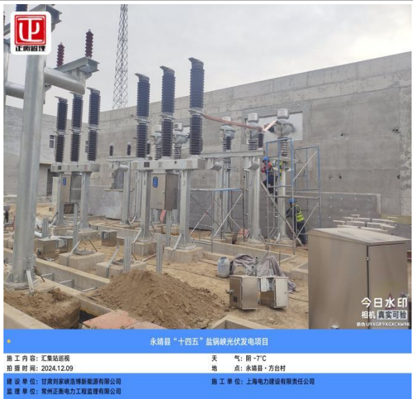
汇集站构架设备安装
