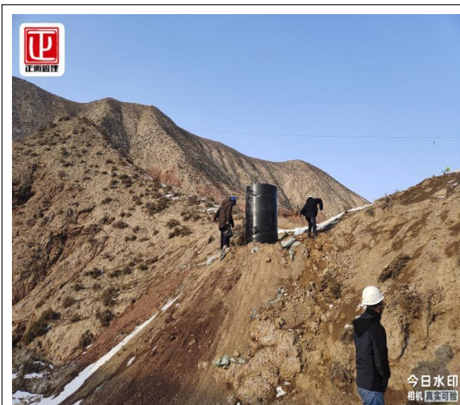
集电线路接地沟、接地验收
