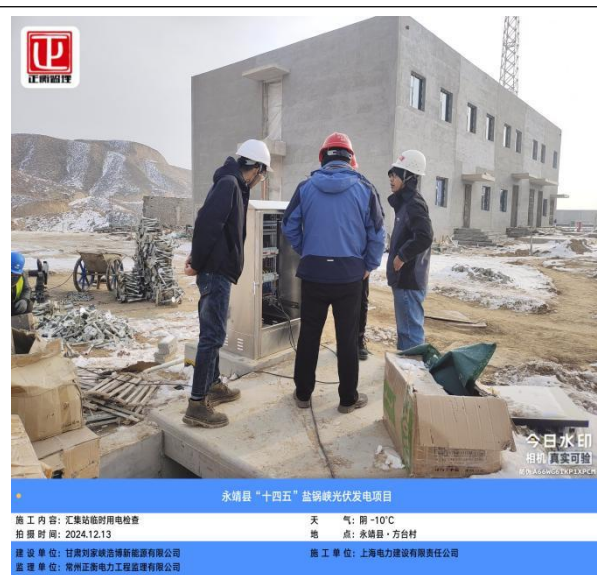
临时用电检查
