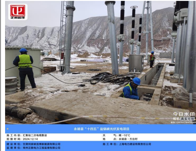
汇集站二次电缆放线
