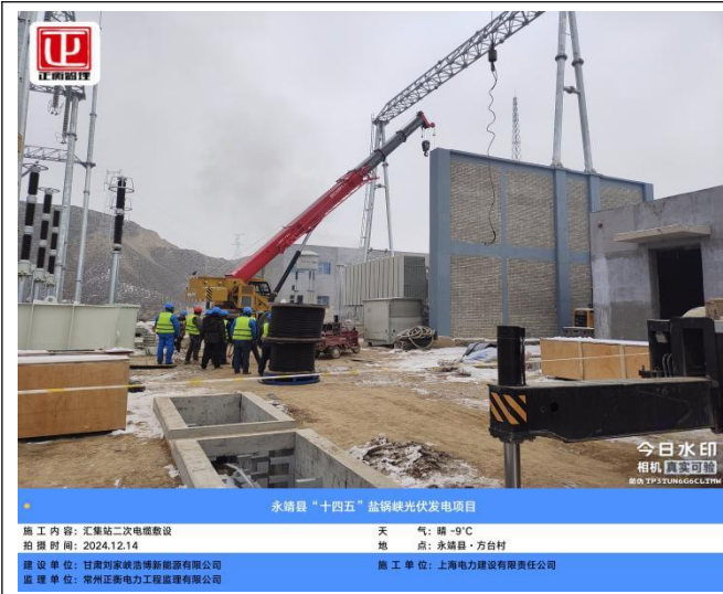
汇集站二次电缆放线
