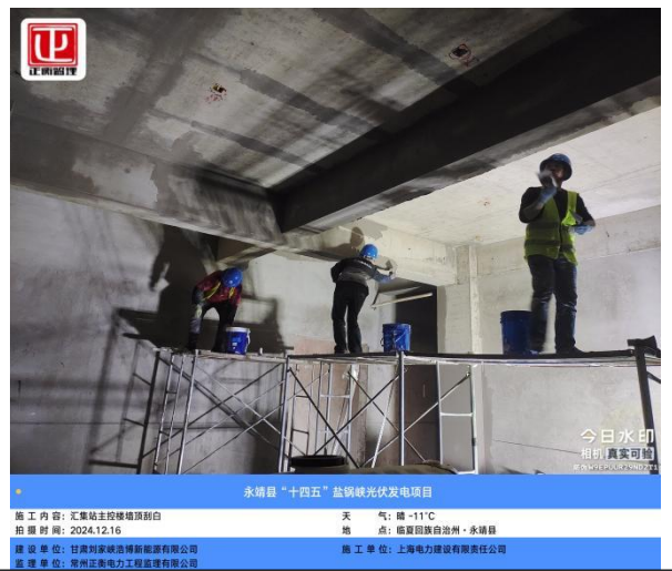
主控楼屋顶刮白
