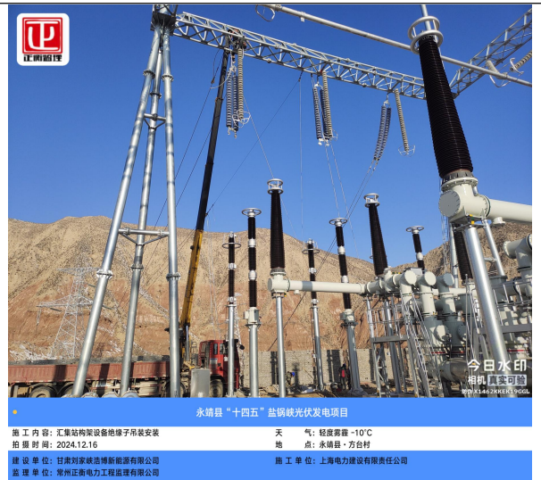
汇集站绝缘子吊装安装
