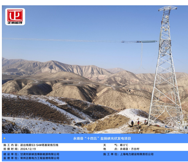
送出线路施工
