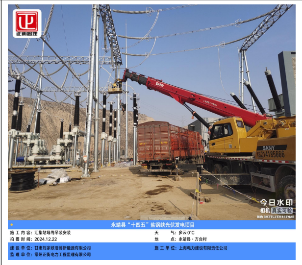
永靖县“十四五”盐钢峡光伏发电项目 施工内容: 汇集站导线吊装安装 拍摄时间: 2024.12.22 建设单位: 甘肃刘家峡清洁能源有限公司 监理单位: 常州正衡电力工程监理有限公司 天气: 多云0°C 地点: 永靖县·方台村 施工单位: 上海电力建设有限责任公司
