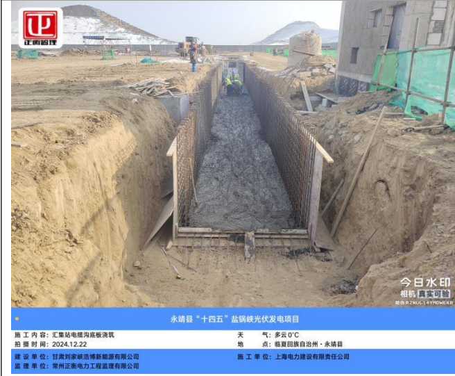
永靖县“十四五”盐钢峡光伏发电项目 施工内容: 汇集站电缆沟底板浇筑 拍摄时间: 2024.12.22 建设单位: 甘肃刘家峡清洁能源有限公司 监理单位: 常州正衡电力工程监理有限公司 天气: 多云0°C 地点: 临夏回族自治州·永靖县 施工单位: 上海电力建设有限责任公司
