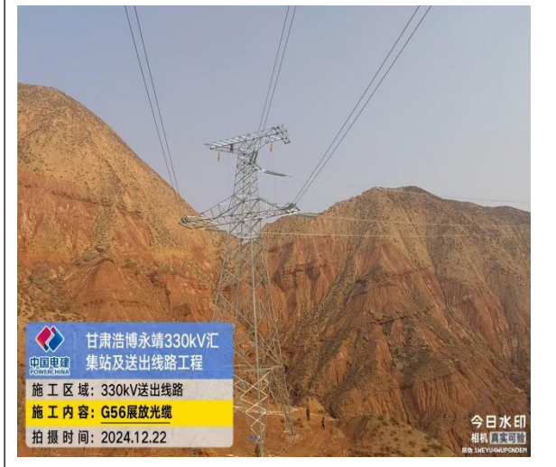
甘肃浩博永靖330kV汇集站及送出线路工程 施工区域: 330kV送出线路 施工内容: G56展放光缆 拍摄时间: 2024.12.22
