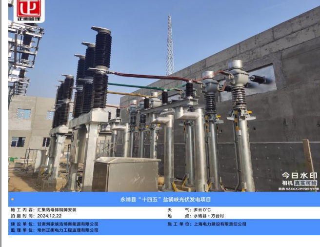
永靖县“十四五”盐钢峡光伏发电项目 施工内容: 汇集站母排铜牌安装 拍摄时间: 2024.12.22 建设单位: 甘肃刘家峡清洁能源有限公司 监理单位: 常州正衡电力工程监理有限公司 天气: 多云0°C 地点: 永靖县·方台村 施工单位: 上海电力建设有限责任公司
