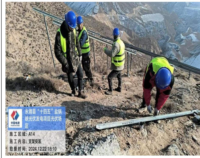
永靖县“十四五”盐钢峡光伏发电项目光场区 施工区域: A14 施工内容: 支架安装 拍摄时间: 2024.12.22 18:10
