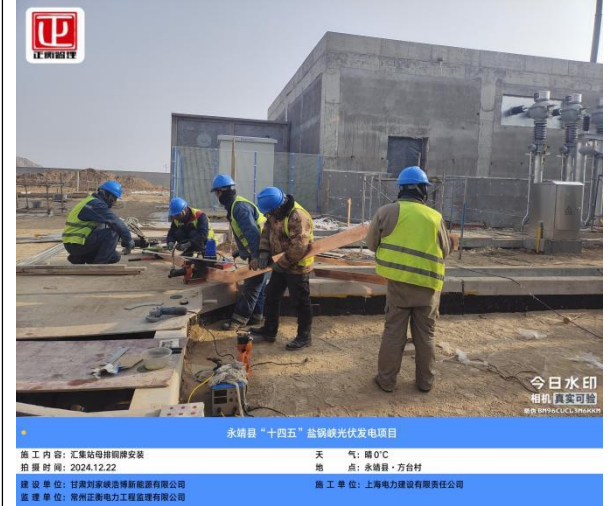
永靖县“十四五”盐钢峡光伏发电项目 施工内容: 汇集站母排铜牌安装 拍摄时间: 2024.12.22 建设单位: 甘肃刘家峡清洁能源有限公司 监理单位: 常州正衡电力工程监理有限公司 天气: 晴0°C 地点: 永靖县·方台村 施工单位: 上海电力建设有限责任公司
