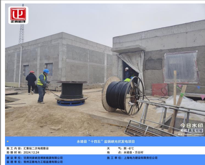
永靖县“十四五”盐锅峡光伏发电项目
