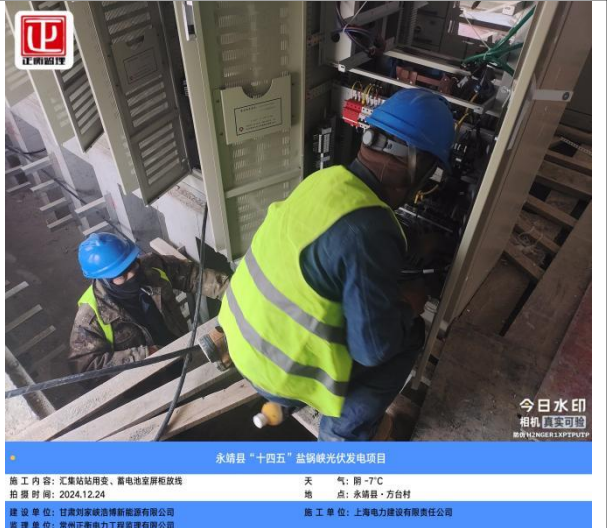
永靖县“十四五”盐锅峡光伏发电项目
