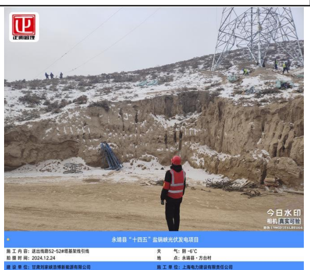
永靖县“十四五”盐锅峡光伏发电项目
