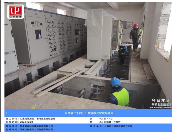
永靖县“十四五”盐锅峡光伏发电项目
