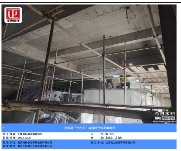
永靖县“十四五”盐锅峡光伏发电项目
