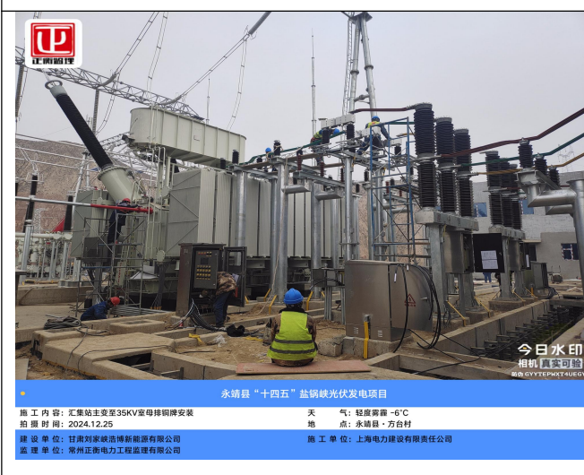
永靖县“十四五”盐锅峡光伏发电项目 施工内容: 汇集站主变至35KV室母排铜牌安装 天气: 轻度雾霾 -6℃ 拍摄时间: 2024.12.25 地点: 永靖县·方台村 建设单位: 甘肃刘家峡清洁能源有限公司 监理单位: 常州正泰电力工程监理有限公司 施工单位: 上海电力建设有限责任公司
