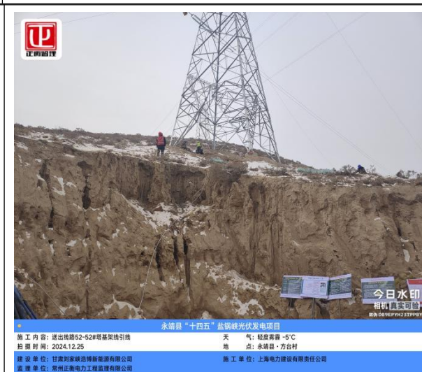
永靖县“十四五”盐锅峡光伏发电项目 施工内容: 送出线路52-52#塔基架线引线 天气: 轻度雾霾 -5℃ 拍摄时间: 2024.12.25 地点: 永靖县·方台村 建设单位: 甘肃刘家峡清洁能源有限公司 监理单位: 常州正泰电力工程监理有限公司 施工单位: 上海电力建设有限责任公司
