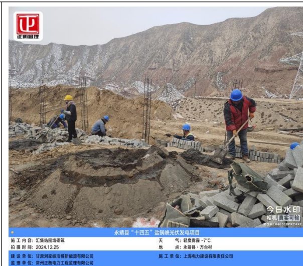
永靖县“十四五”盐锅峡光伏发电项目 施工内容: 汇集站围墙砌筑 天气: 轻度雾霾 -7℃ 拍摄时间: 2024.12.25 地点: 永靖县·方台村 建设单位: 甘肃刘家峡清洁能源有限公司 监理单位: 常州正泰电力工程监理有限公司 施工单位: 上海电力建设有限责任公司
