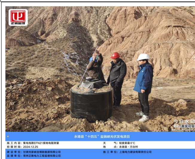
永靖县“十四五”盐锅峡光伏发电项目 施工内容: 集电线路EFN21接地电阻测量 天气: 轻度雾霾 0℃ 拍摄时间: 2024.12.25 地点: 永靖县·方台村 建设单位: 甘肃刘家峡清洁能源有限公司 监理单位: 常州正泰电力工程监理有限公司 施工单位: 上海电力建设有限责任公司
