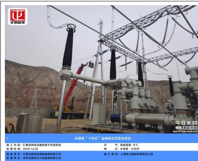
永靖县“十四五”盐锅峡光伏发电项目 施工内容: 汇集站构架绝缘子吊装安装 天气: 轻度雾霾 -6℃ 拍摄时间: 2024.12.25 地点: 永靖县·方台村 建设单位: 甘肃刘家峡清洁能源有限公司 监理单位: 常州正泰电力工程监理有限公司 施工单位: 上海电力建设有限责任公司
