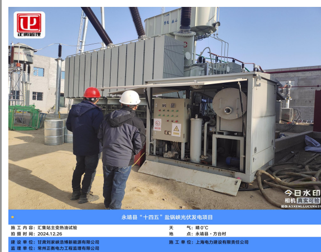
永靖县“十四五”盐锅峡光伏发电项目 施工内容: 汇集站主变热油试验 天气: 晴, 0°C 拍摄时间: 2024.12.26 地点: 永靖县·方台村 建设单位: 甘肃刘家峡清洁能源有限公司 监理单位: 常州正泰电力工程监理有限公司 施工单位: 上海电力建设有限责任公司
