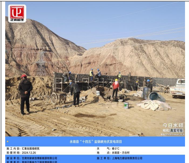
永靖县“十四五”盐锅峡光伏发电项目 施工内容: 汇集站围墙砌筑 天气: 晴, 0°C 拍摄时间: 2024.12.26 地点: 永靖县·方台村 建设单位: 甘肃刘家峡清洁能源有限公司 监理单位: 常州正泰电力工程监理有限公司 施工单位: 上海电力建设有限责任公司
