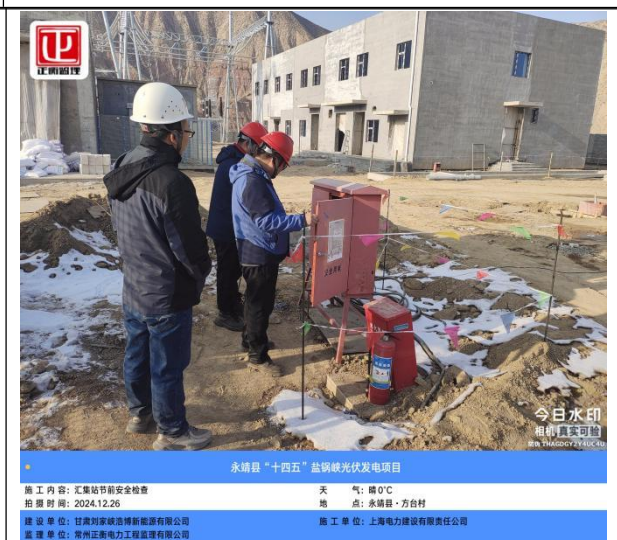
永靖县“十四五”盐锅峡光伏发电项目 施工内容: 汇集站节前安全检查 天气: 晴, 0°C 拍摄时间: 2024.12.26 地点: 永靖县·方台村 建设单位: 甘肃刘家峡清洁能源有限公司 监理单位: 常州正泰电力工程监理有限公司 施工单位: 上海电力建设有限责任公司
