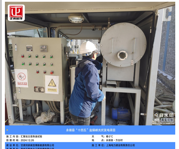
永靖县“十四五”盐锅峡光伏发电项目 施工内容: 汇集站主变热油试验 天气: 晴, 0°C 拍摄时间: 2024.12.26 地点: 永靖县·方台村 建设单位: 甘肃刘家峡清洁能源有限公司 监理单位: 常州正泰电力工程监理有限公司 施工单位: 上海电力建设有限责任公司
