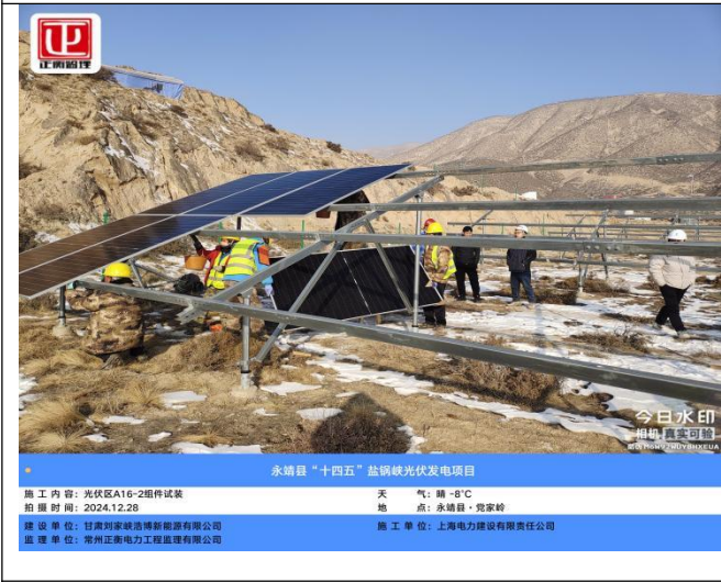
组件开箱检查、试装
