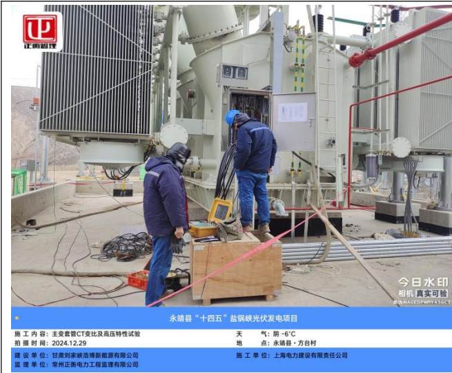
主变套管 ct 变比试验
