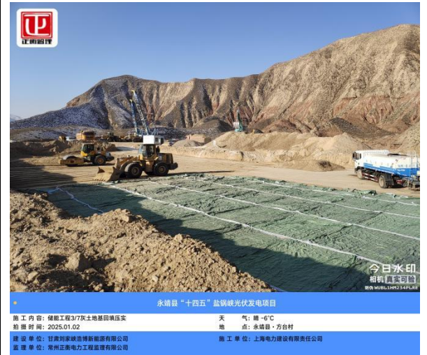
汇集站储能工程地基施工
