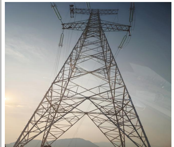
送出线路铁塔架线
