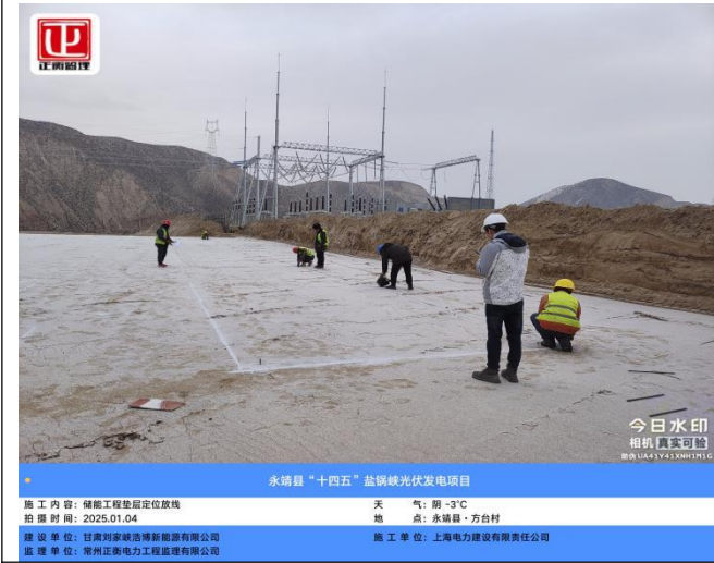
永靖县“十四五”盐锅峡光伏发电项目 施工内容: 储能工程垫层定位放线 天气: 阴 -3℃ 拍摄时间: 2025.01.04 地点: 永靖县·方台村 建设单位: 甘肃刘家峡清洁能源有限公司 监理单位: 常州正衡电力工程监理有限公司 施工单位: 上海电力建设有限责任公司
