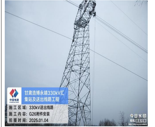
送出线路铁塔架线
