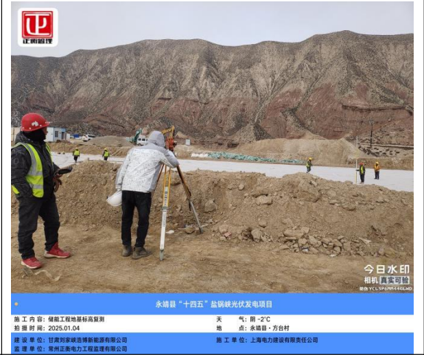
永靖县“十四五”盐锅峡光伏发电项目 施工内容: 储能工程地基标高复测 天气: 阴 -2℃ 拍摄时间: 2025.01.04 地点: 永靖县·方台村 建设单位: 甘肃刘家峡清洁能源有限公司 监理单位: 常州正衡电力工程监理有限公司 施工单位: 上海电力建设有限责任公司
