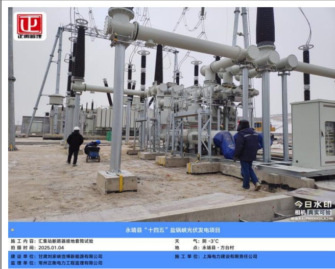
永靖县“十四五”盐锅峡光伏发电项目 施工内容: 汇集站断路器接地套筒试验 天气: 阴 -3℃ 拍摄时间: 2025.01.04 地点: 永靖县·方台村 建设单位: 甘肃刘家峡清洁能源有限公司 监理单位: 常州正衡电力工程监理有限公司 施工单位: 上海电力建设有限责任公司
