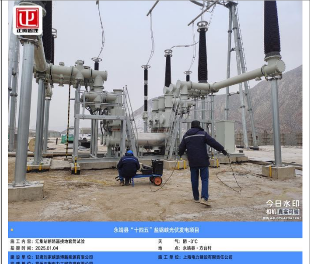
永靖县“十四五”盐锅峡光伏发电项目 施工内容: 汇集站断路器接地套筒试验 天气: 阴 -3℃ 拍摄时间: 2025.01.04 地点: 永靖县·方台村 建设单位: 甘肃刘家峡清洁能源有限公司 监理单位: 常州正衡电力工程监理有限公司 施工单位: 上海电力建设有限责任公司
