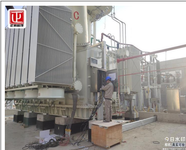
汇集站主变高压柜接线
