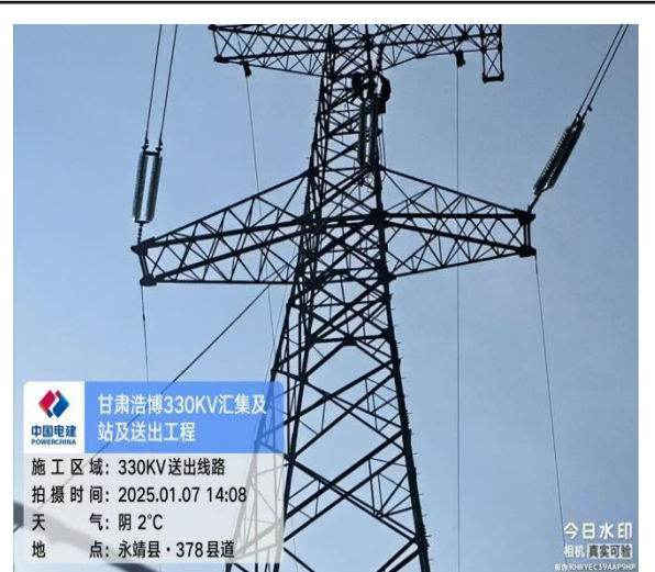
送出线路铁塔架线
