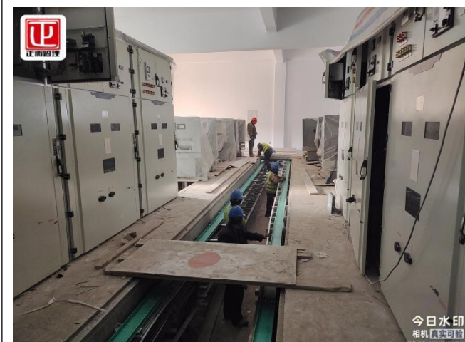
汇集站主变高压柜接线
