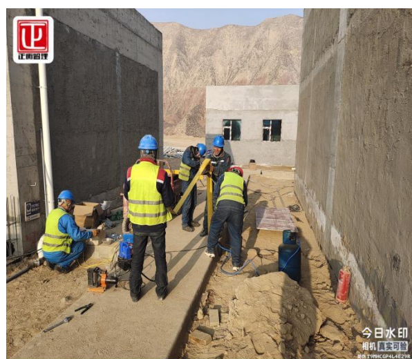
汇集站铜牌施工
