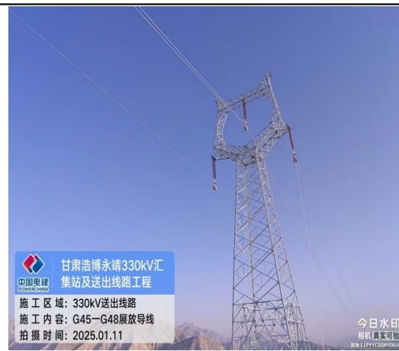
送出线路铁塔架线
