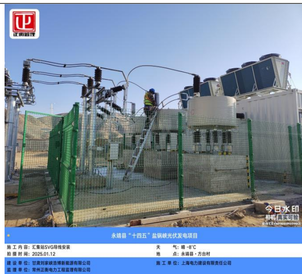
汇集站 SVG 导线安装
