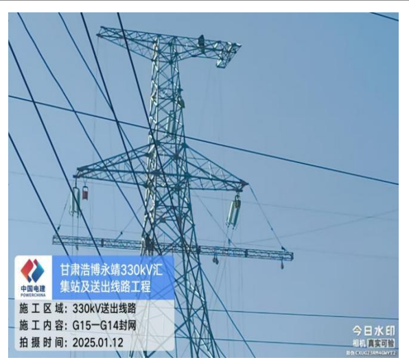
送出线路铁塔架线
