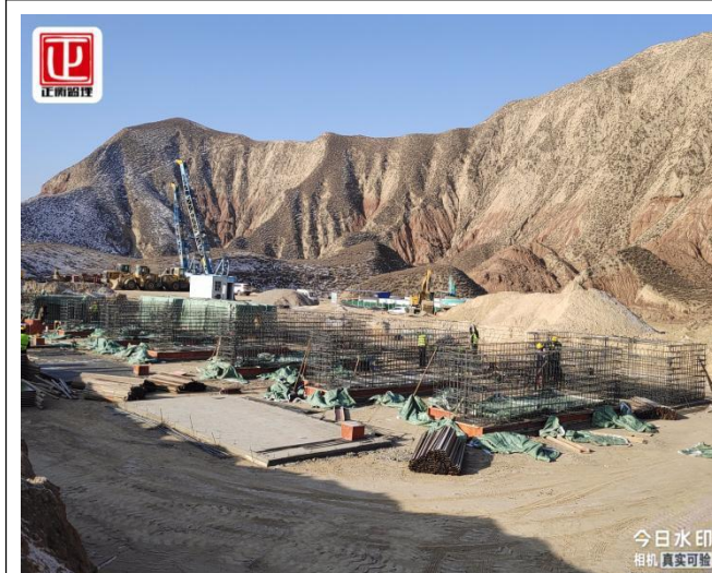
储能基础钢筋施工
