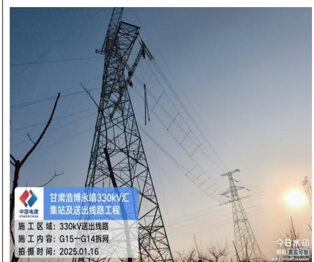
送出线路施工
