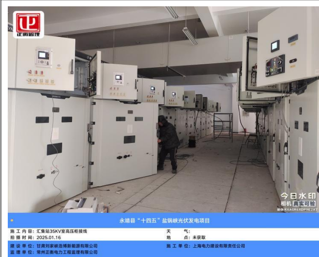
汇集站 35KV 高压柜接线、调试
