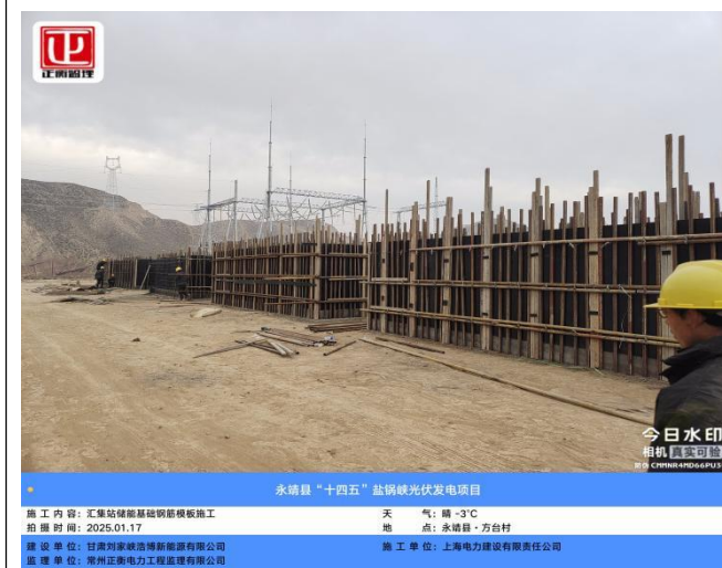
储能基础施工
