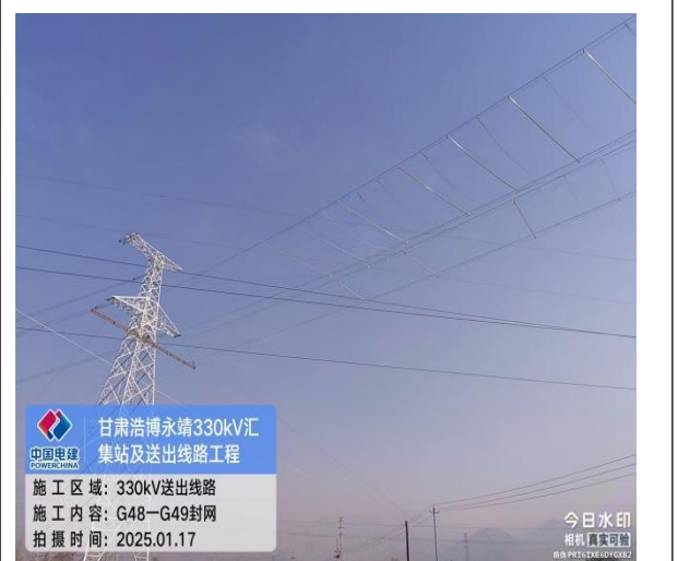
送出线路施工
