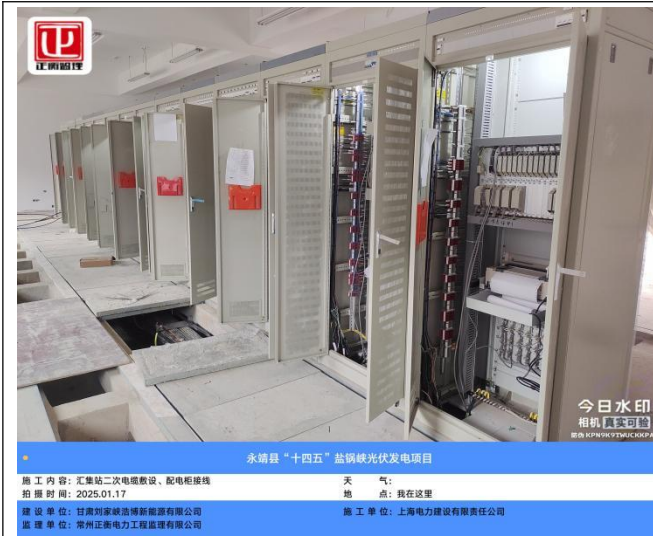
汇集站二次电缆敷设、配电柜接线
