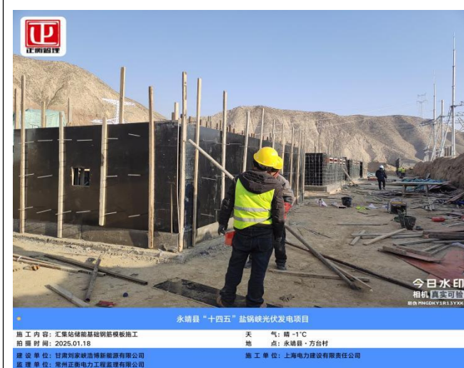
储能基础施工
