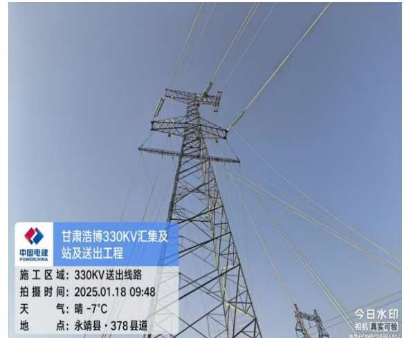
送出线路施工
