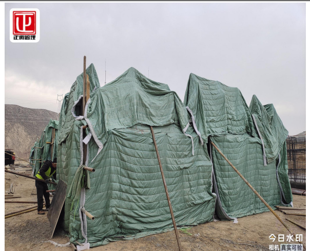
汇集站基础混凝土养护
