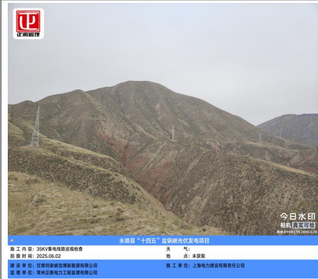
集电线路巡视检查
