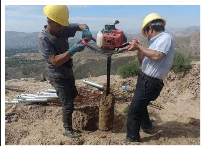
光伏区基础桩整改巡视检查
