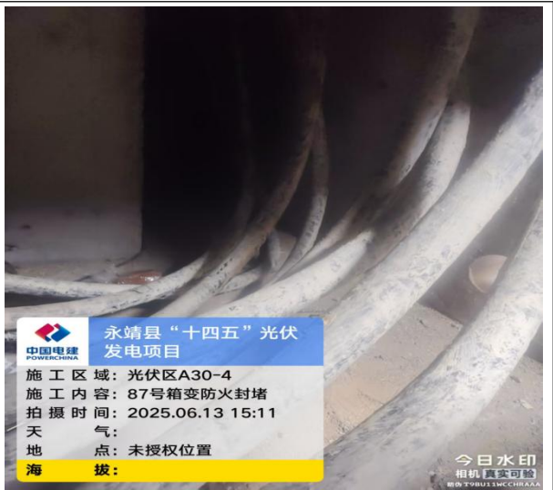
电缆刷防火涂料
