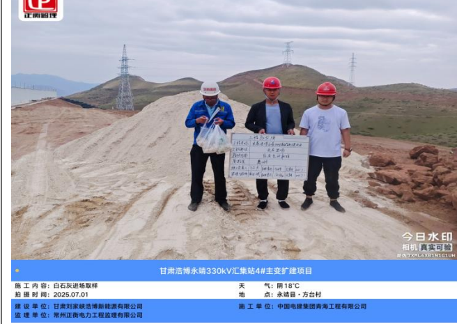
甘肃浩博永靖330kV汇集站4#主变扩建项目 施工内容: 白石灰进场取样 天气: 阴 18℃ 拍摄时间: 2025.07.01 地点: 永靖县·万台村 建设单位: 甘肃刘家峡清洁能源开发有限公司 施工单位: 中国电建集团青海工程有限公司 监理单位: 常州正泰电力工程监理有限公司
