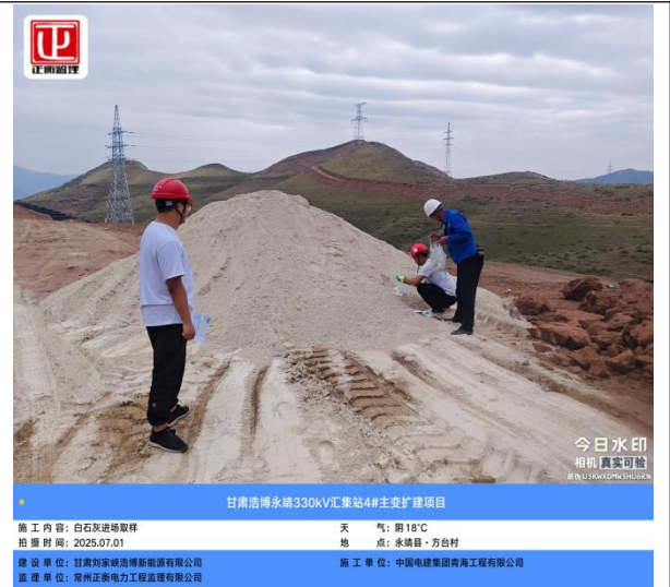
甘肃浩博永靖330kV汇集站4#主变扩建项目 施工内容: 白石灰进场取样 天气: 阴 18℃ 拍摄时间: 2025.07.01 地点: 永靖县·万台村 建设单位: 甘肃刘家峡清洁能源开发有限公司 施工单位: 中国电建集团青海工程有限公司 监理单位: 常州正泰电力工程监理有限公司
