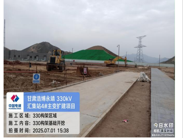
甘肃浩博永靖 330kV 汇集站4#主变扩建项目 施工区域: 330构架区域 施工内容: 330构架基础开挖 拍摄时间: 2025.07.01 15:38
