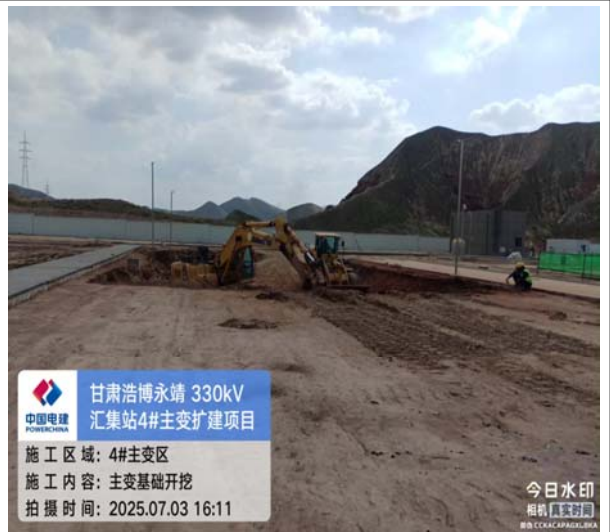
基坑开挖巡视
