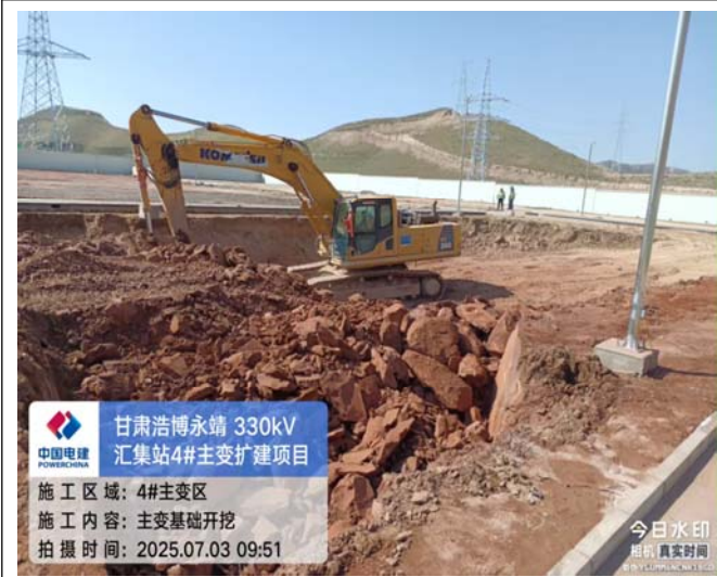
基坑开挖巡视
