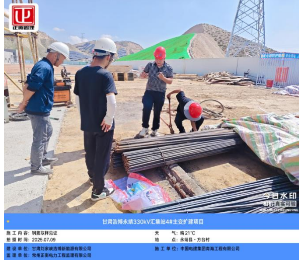
钢筋见证取样
