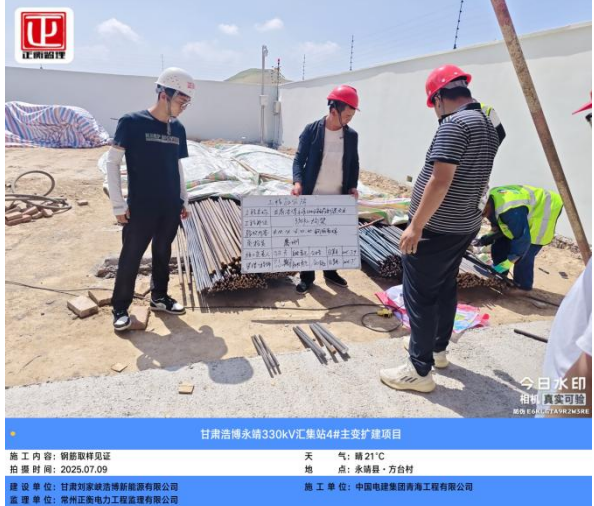
钢筋见证取样
