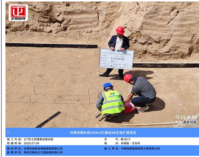
3/7 灰土回填密实度取样、试验
