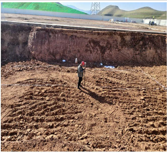
基坑开挖、基准点复测巡视
