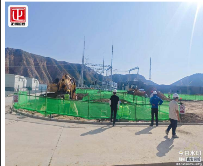
基坑开挖巡视
