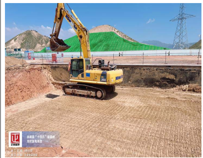
灰土回填压实
