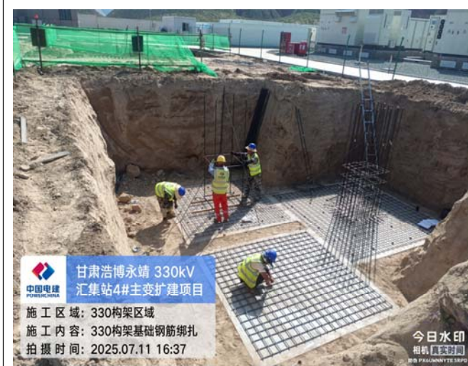
构架基础钢筋绑扎
