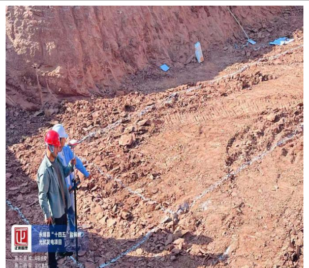
基坑开挖、基准点复测巡视
