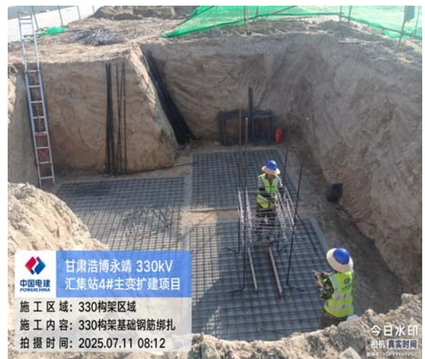
构架基础钢筋绑扎
