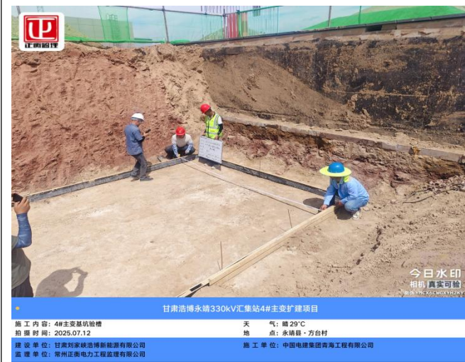
4#主变、防火墙地基验槽
