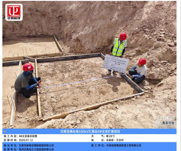
4#主变、防火墙地基验槽
