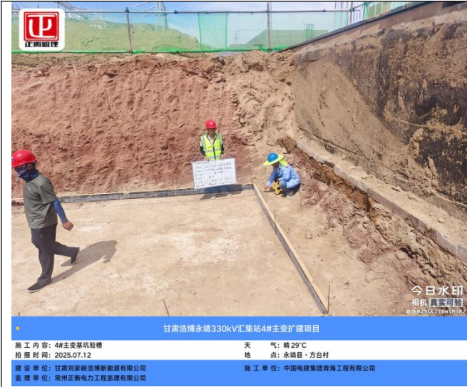
4#主变、防火墙地基验槽
