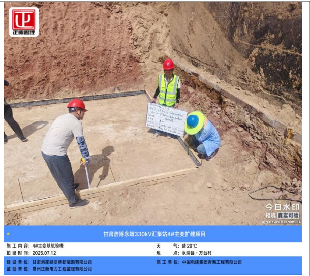
4#主变、防火墙地基验槽
