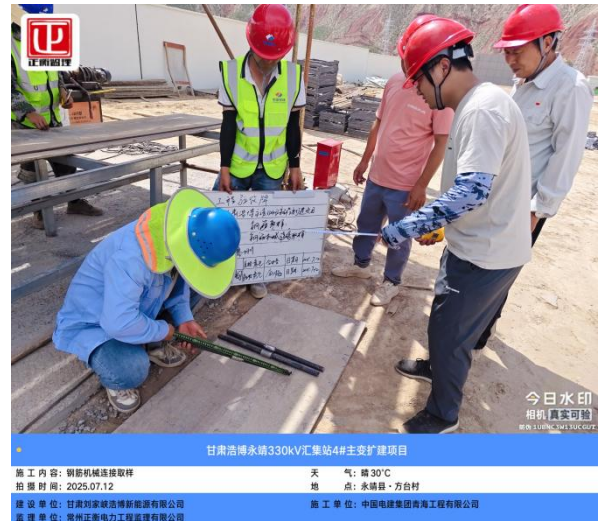
钢筋机械连接见证取样
