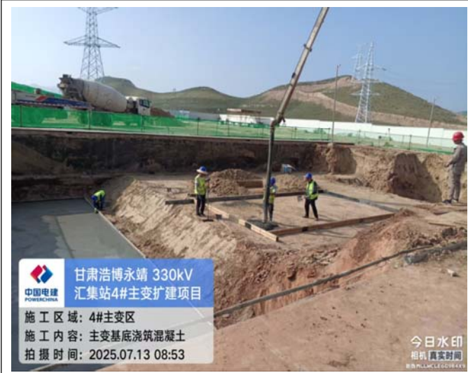
4#主变、防火墙垫层浇筑
