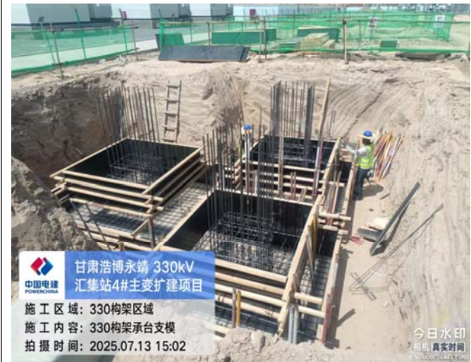
构架基础承台钢筋绑扎
