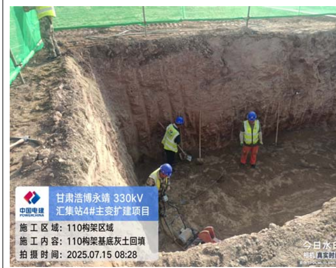
110kv 构架基础灰土回填
