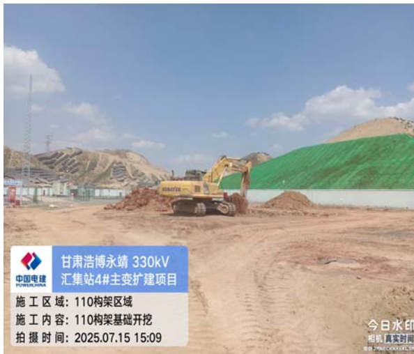
110kv 构架基础基坑开挖
