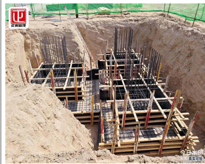
330kv 构架基础承台钢筋、模板检查
