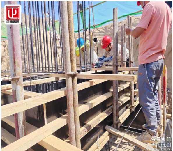
330kv 构架基础承台钢筋、模板检查
