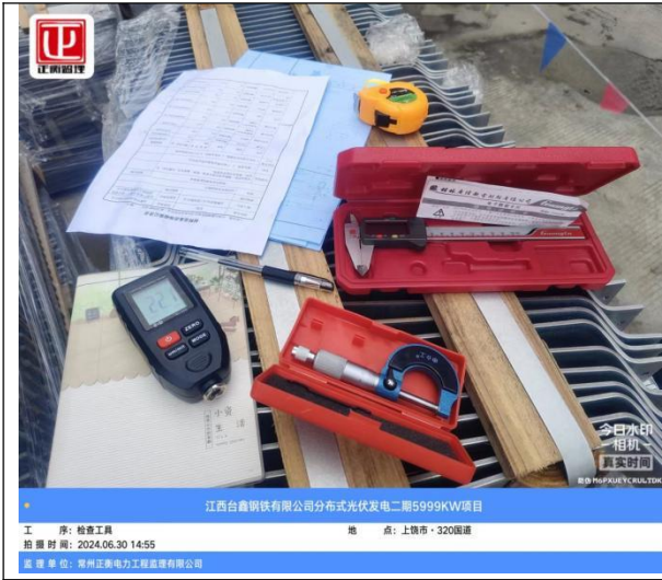
BIPV 支架检查准备
