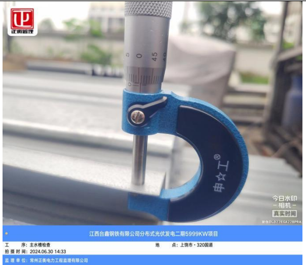
主水槽厚度检查
