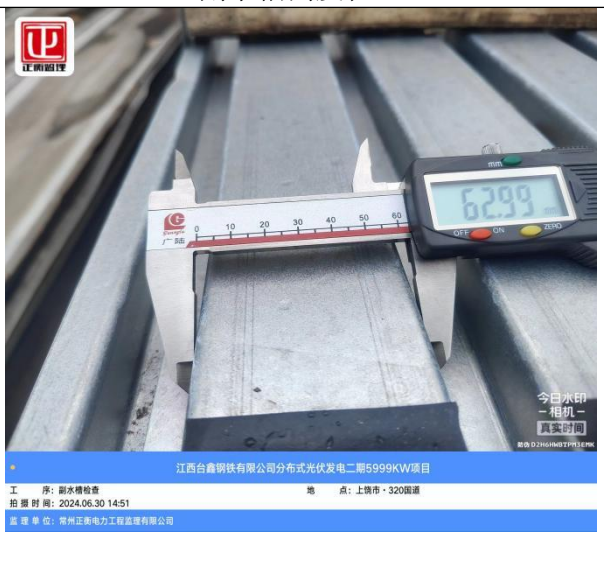
副水槽宽度检查
