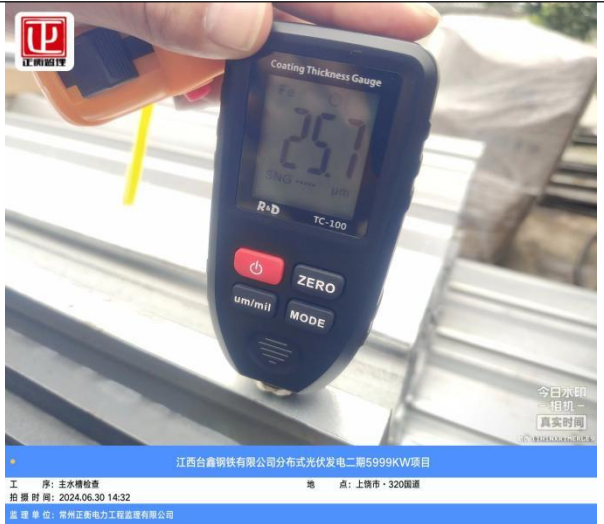
主水槽涂层检查
