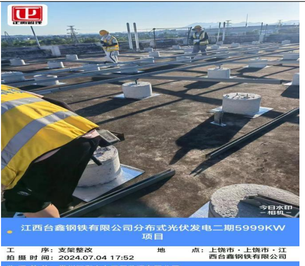
接待楼支架拆解
