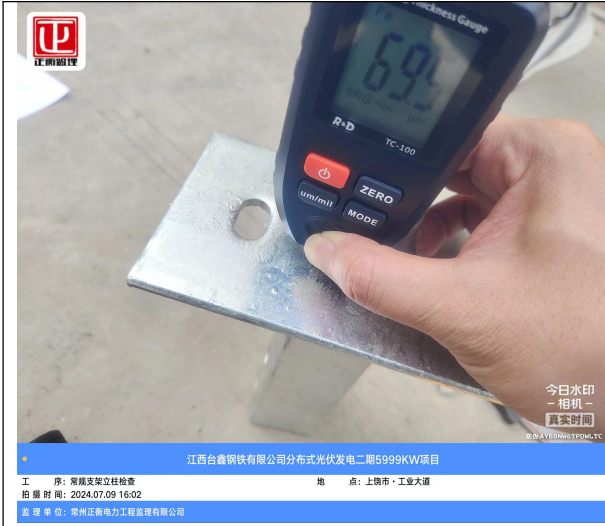
立柱镀锌层检查
