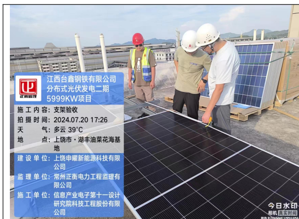
水泥屋面支架验收
