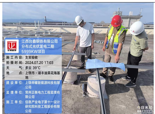
水泥屋面支架验收
