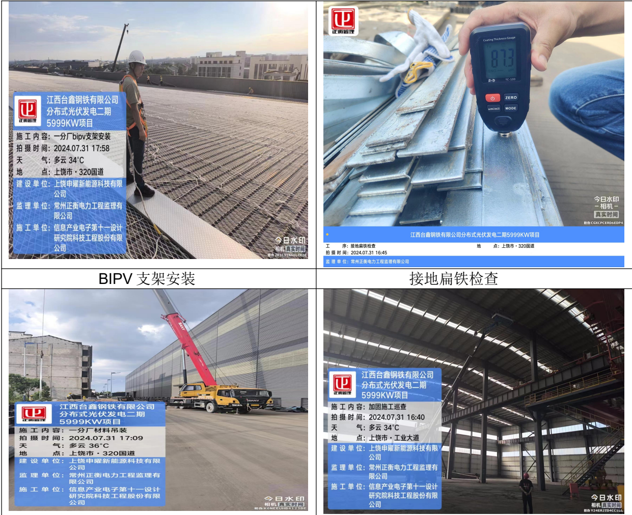
附一：施工过程及监督检查图片
