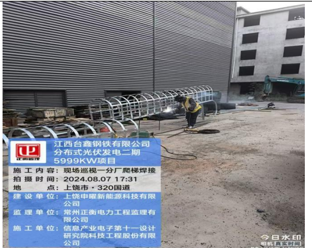
一分厂现场爬梯安装检查
