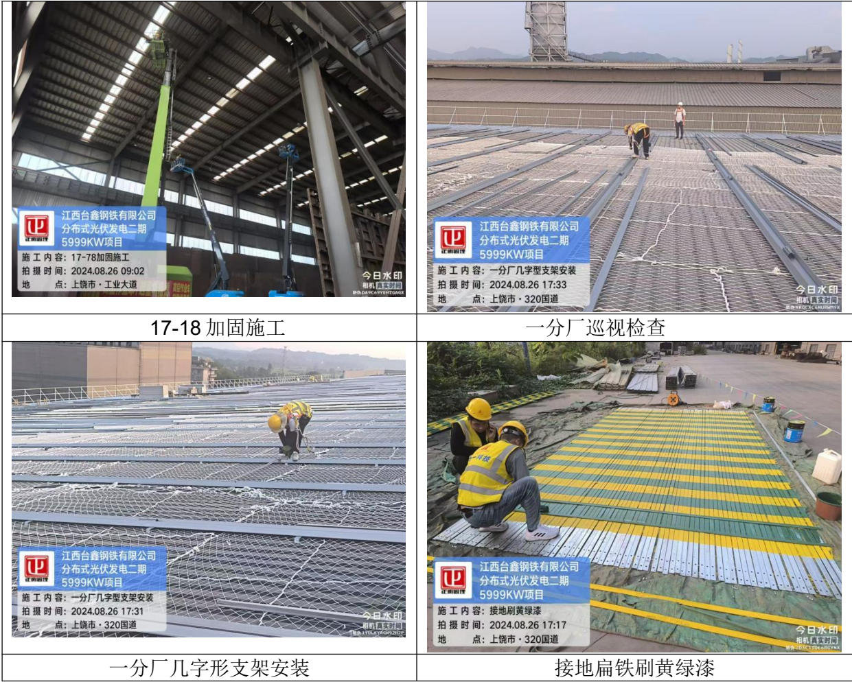
附一：施工过程及监督检查图片
